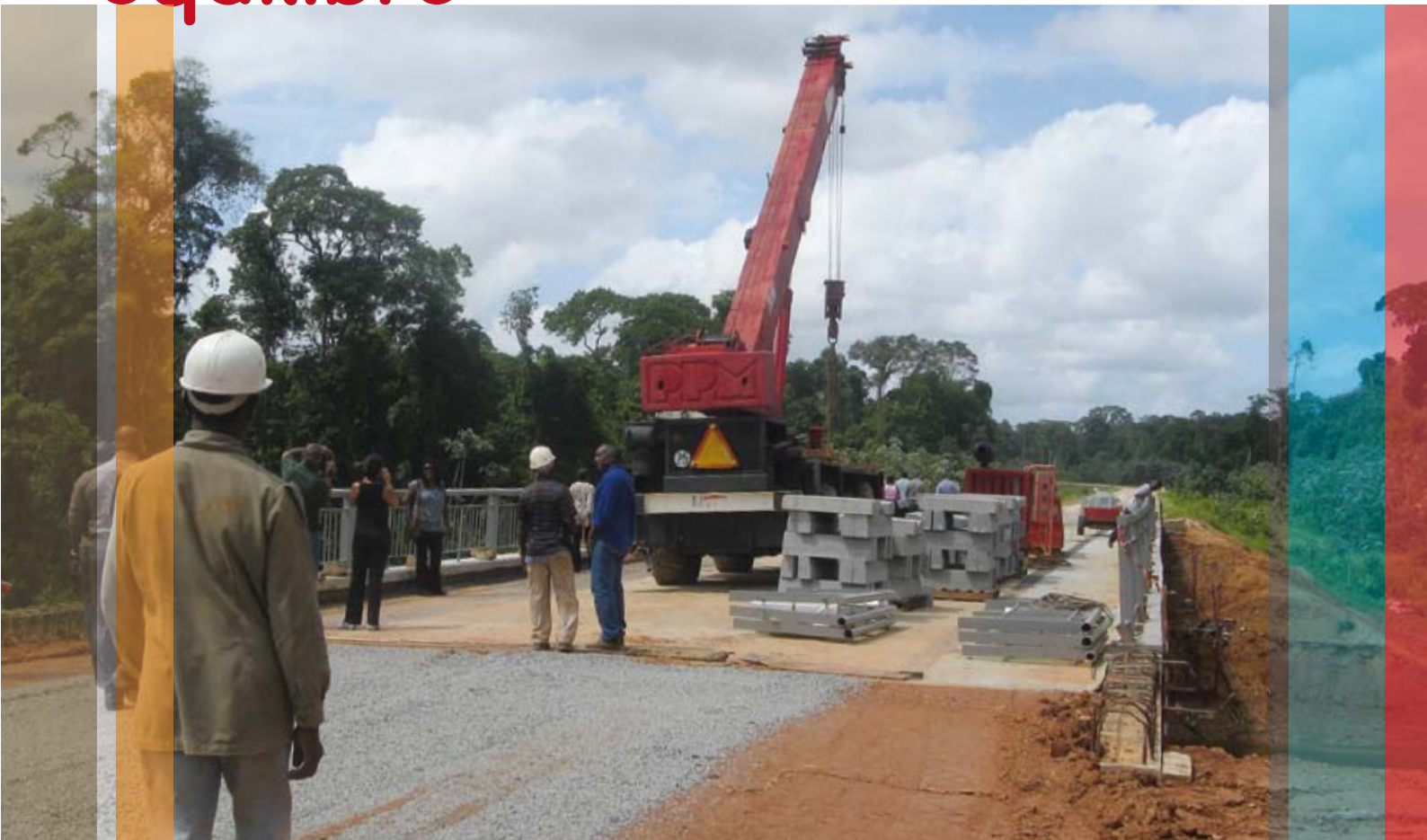
Construction du pont sur la route du fleuve Saint-Laurent/Apatou
