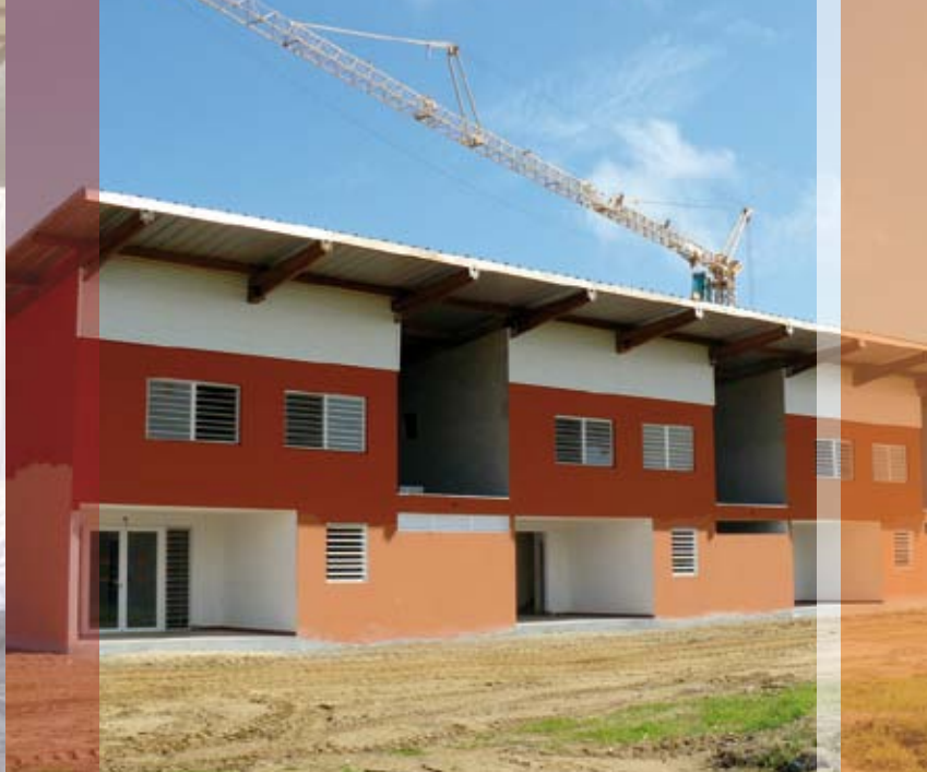
Le lycée professionnel II de Kourou en cours d'achèvement
